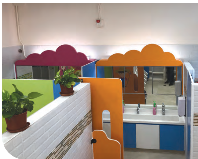
仁愛堂吳黃鳳英幼稚園暨幼兒園 — 洗手間翻新工程。
